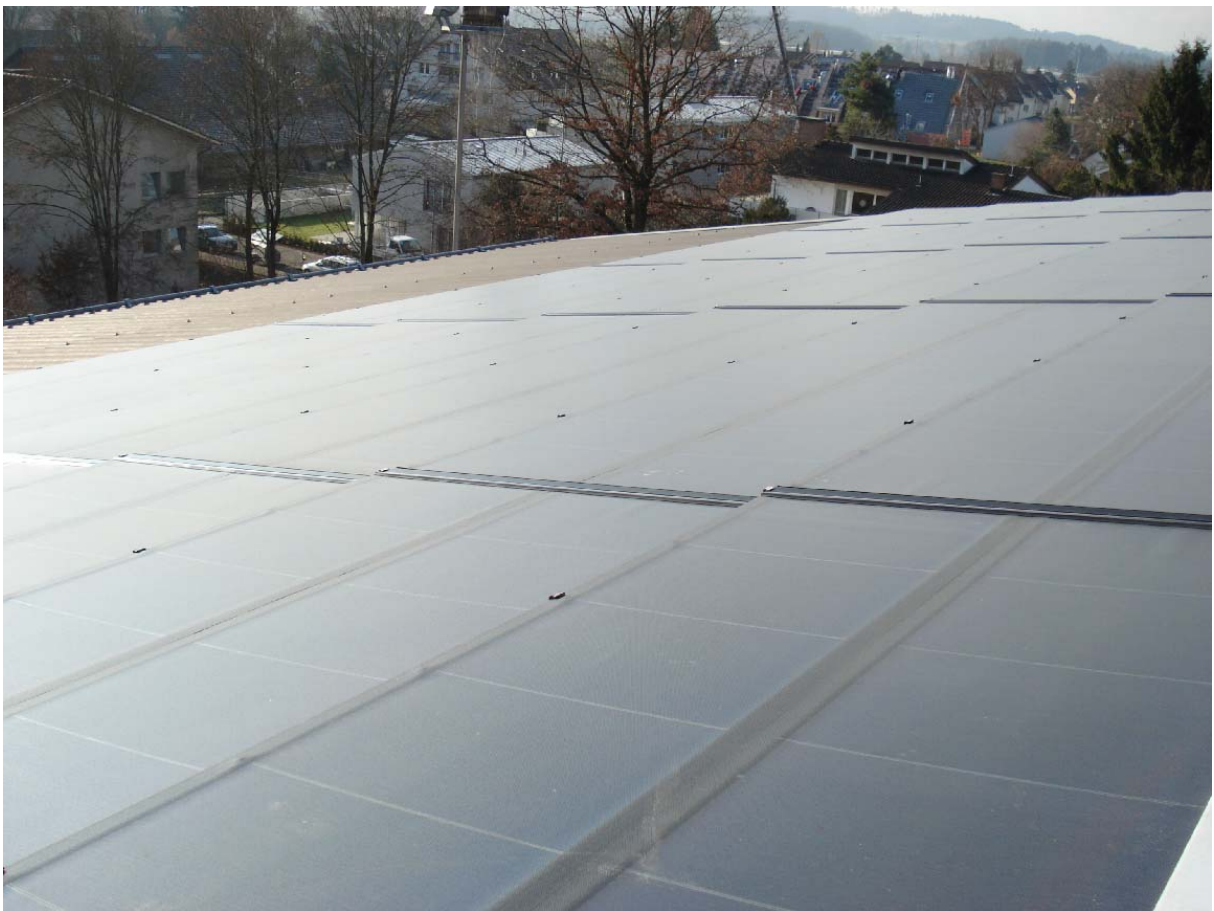
Figur 14: Foto der Anlage Turnhalle Wiesendangen mit Biosol XXL-Elementen (Quelle: Enecolo AG)
