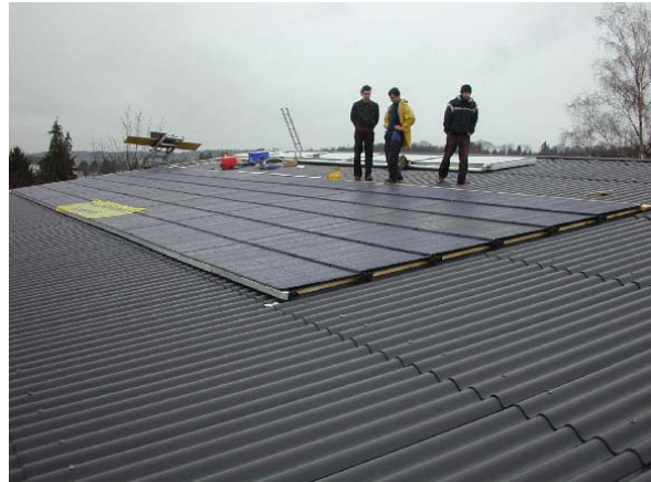
Figur 2: Fertig verlegte Generatorfläche
