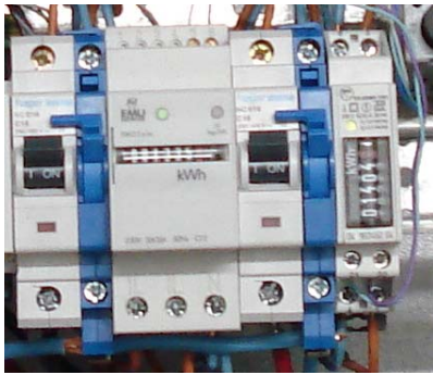
Figur 6: Energiezähler
