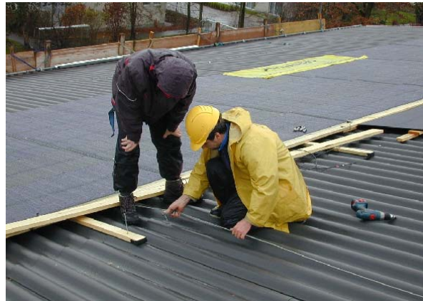
Figur 11: Vorbereiten der Unterkonstruktion
