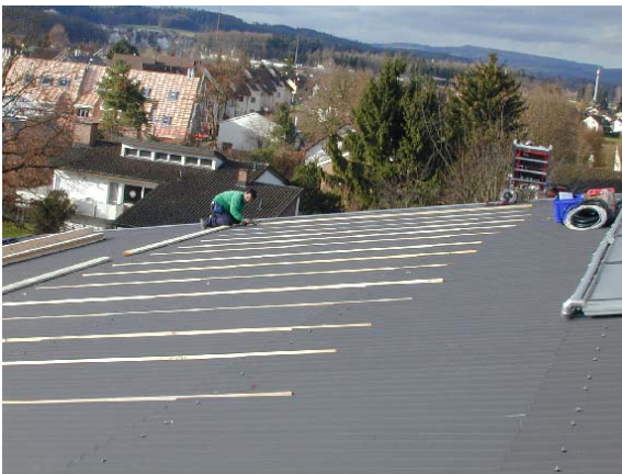
Figur 1: Lattenrost auf das bestehende Dach
