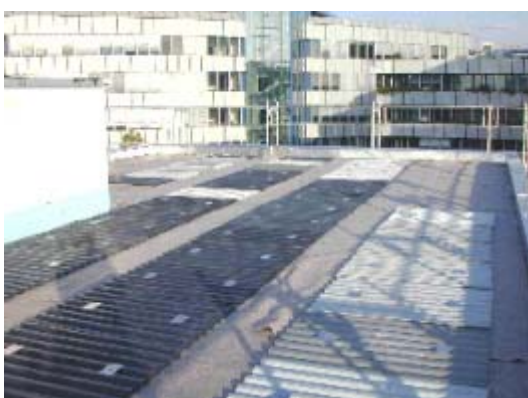
Abb. 6: Deltatec-Platten werden auf dem Dach verlegt und dienen als Anker der Konstruktion
