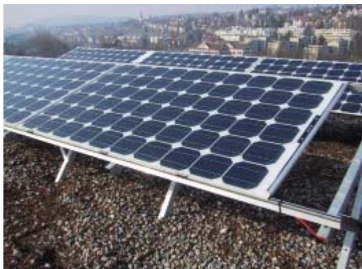
Abb. 21: Standard Unterkonstruktion mit horizontalem Modul-Befestigungsprofil
