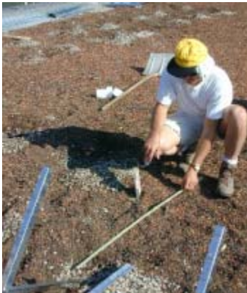
Abb. 10: Freilegen der Edelstahlplatten
