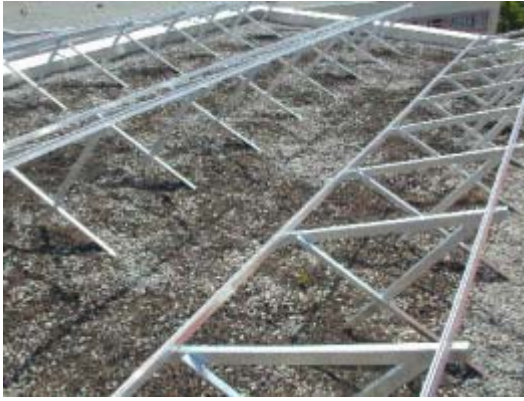
Abb. 8: Die Unterkonstruktion wird auf den
