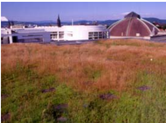
Abb. 43: Dachbegrünung UBS Ausbildungszentrum
