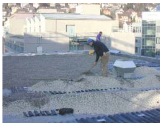
Abb. 7: Die gelegten Deltatec-Platten werden anschliessend mit Bodensubstrat beschwert.
