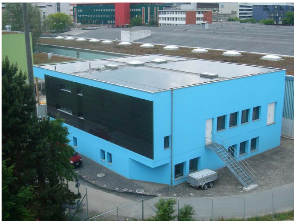
Bild 6: PVA Spielleute Luzern mit 4.5kW fassaden- und 15kW-dachintegriert
