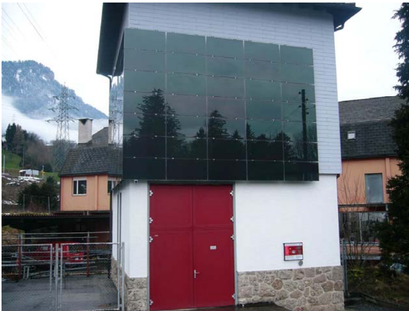
Bild 4: Ostfassade mit Eingang ins Trafogebäude und Anzeigetafel
