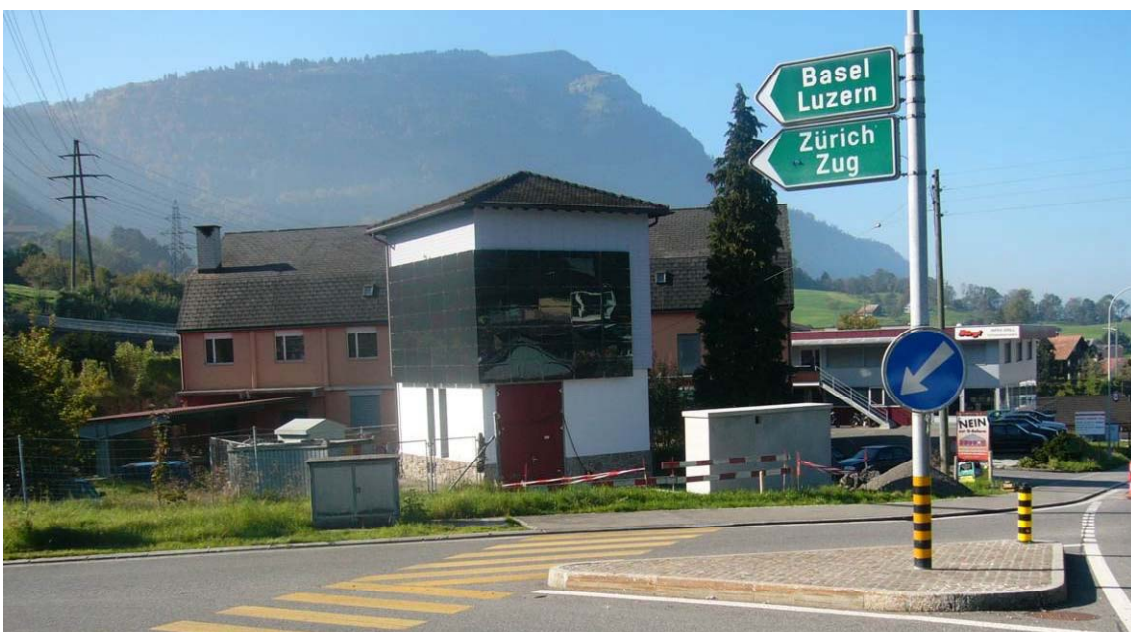
Bild 3: Trafogebäude Wichel in Goldau, Gemeindewerke Arth, Ansicht Süd- und Ostfassade
