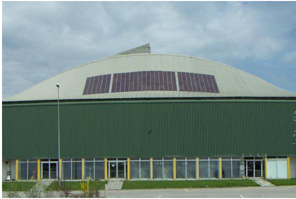
Figure 9 : Toiture Flexcell expérimentale de 2 kW c (Source: VHF-Technologies)
