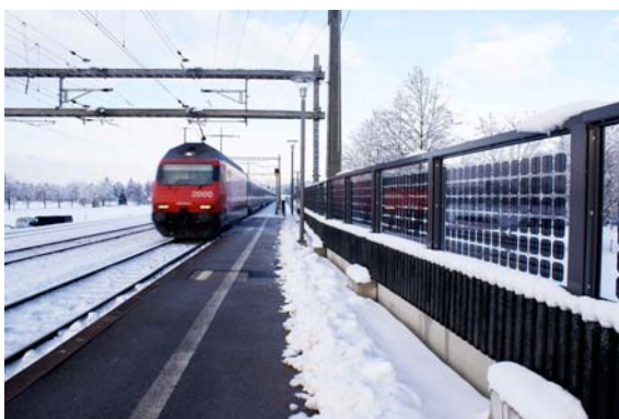
Figure 7: Barrière photovoltaïque anti-bruit à deux faces (Source: TNC)
