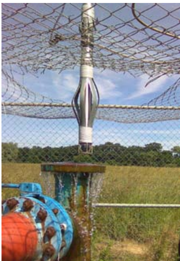
Figure 4: Restauration du forage de Thônex en vue d'une production d'énergie thermique [12]
