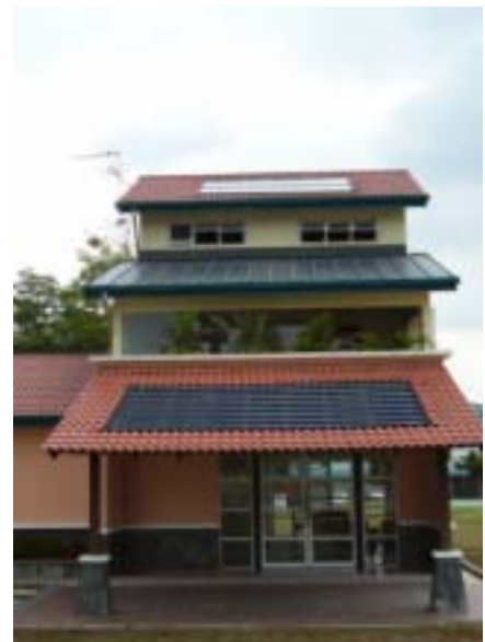
Figur 2: Gebäudeintegrierte Anlage in Malaysia, Bildquelle: Enecolo
