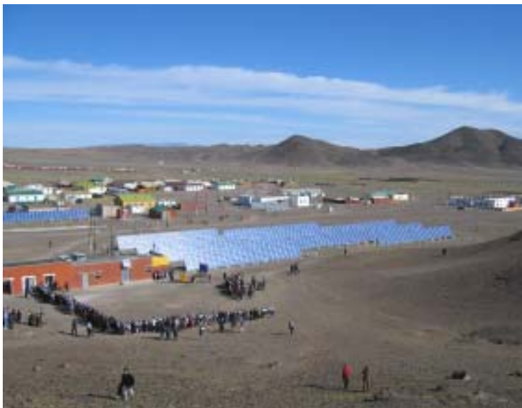
Figur 1: Photovoltaik Anlage in der Mongolei, Bildquelle: entec
