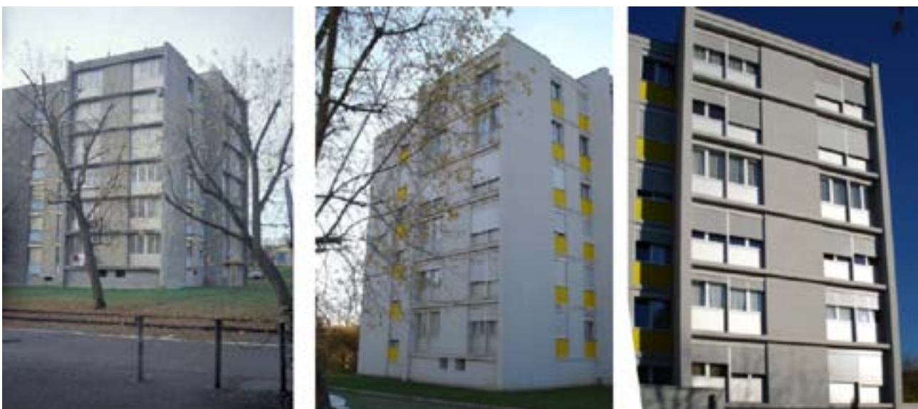
Figur 2 : Tours Cayla in Genf vor Sanierung (links), mit Aussendämmung (Mitte) und mit Innendämmung (rechts) (Bild W. Weber)
