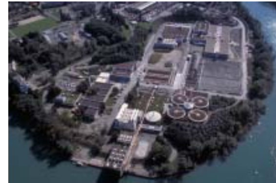
Stations traitement des eaux usées
