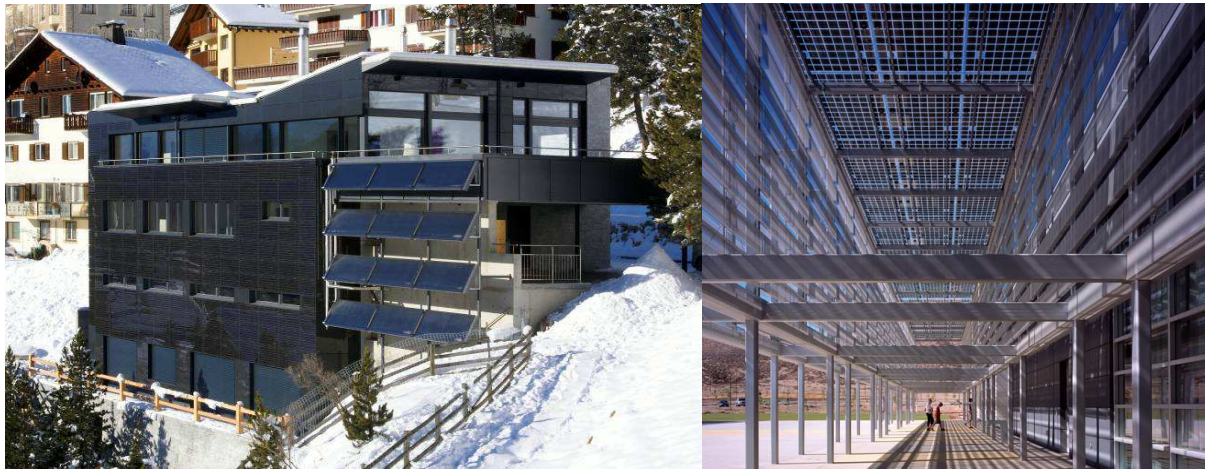
Bild 8 - Durch 3S realisierte gebäudeintegrierte Solaranlagen
