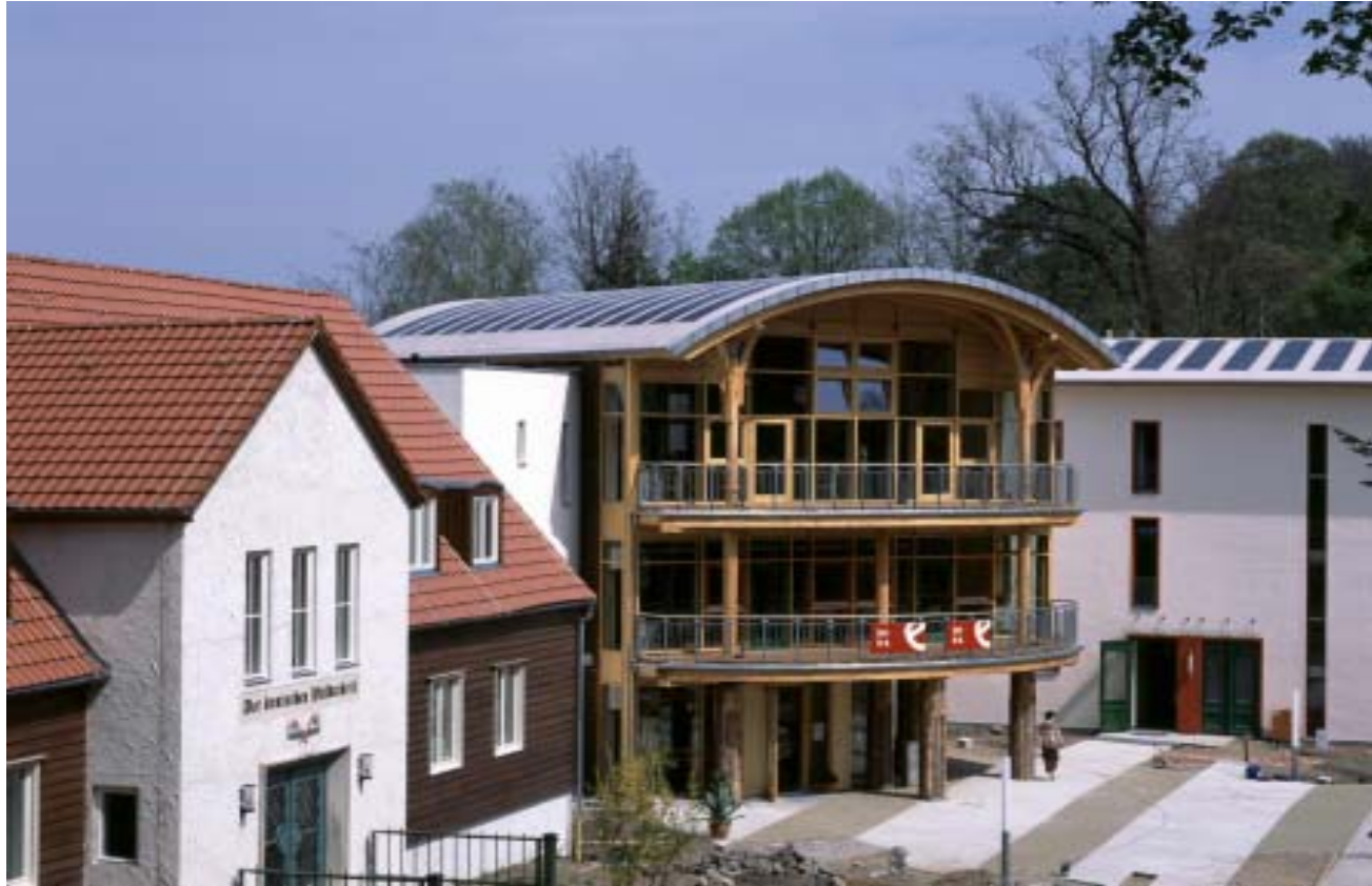
Wald Solar Heim, Eberswalde, 2004, 10,2 kWp
