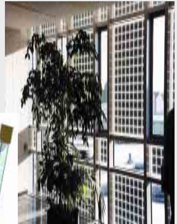
Exemple d'une fenêtre à double vitrage avec PV
