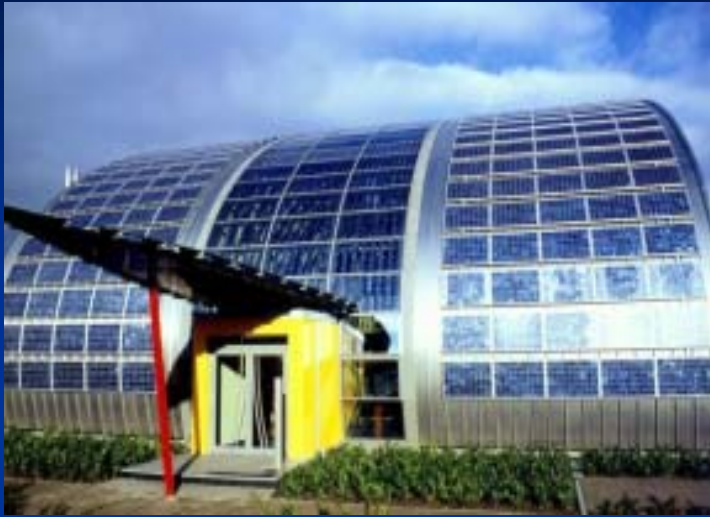
Solar factory, Gelsenkirchen DE
